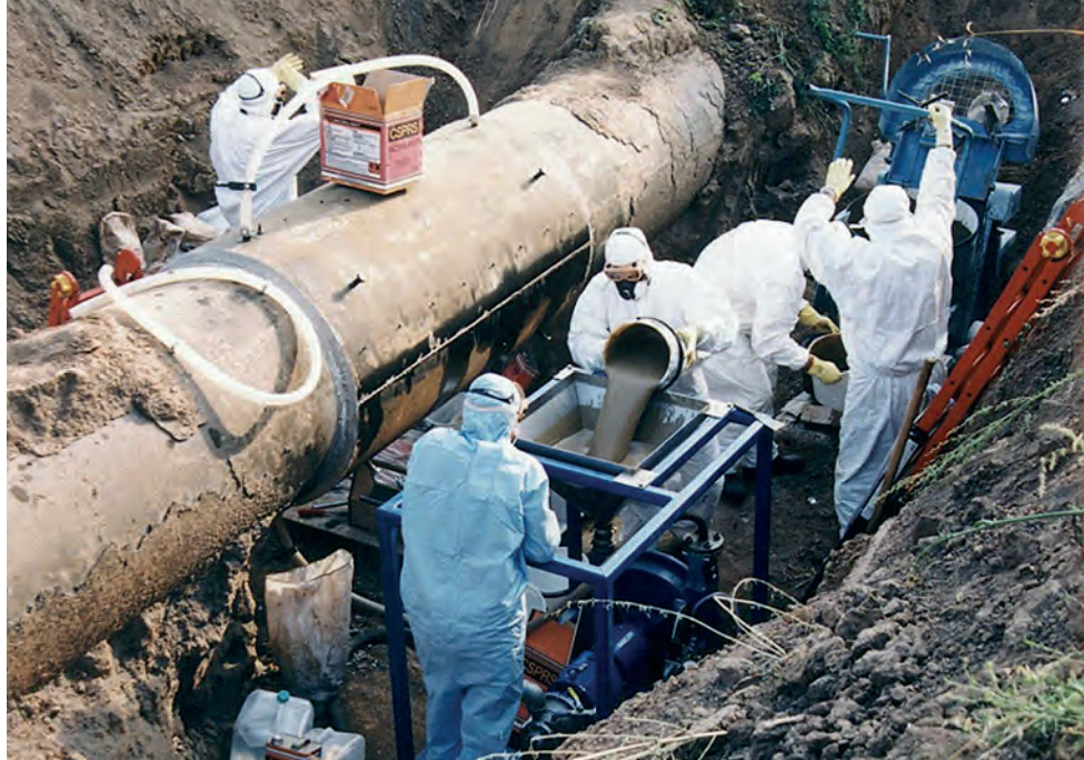
Установка муфты, изготовленной по композитно-муфтовой технологии
