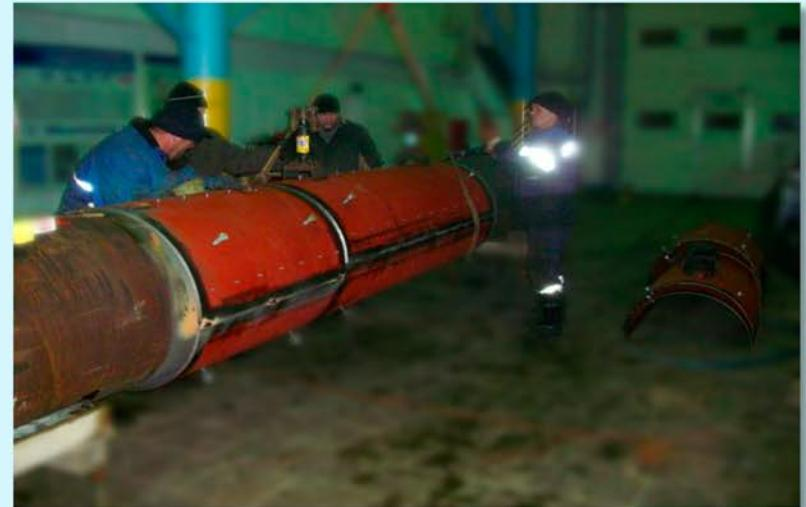
*3) Регулировка кольцевого зазора между трубой и муфтой проводится установочными болтами с учетом геометрии трубы.*
