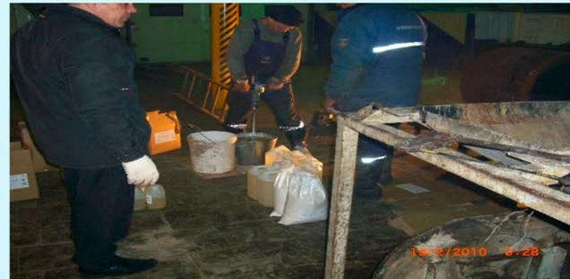
**6) Заполнение композитным составом кольцевого зазора муфты с помощью нагнетательного насоса с приемочным бункером.**
